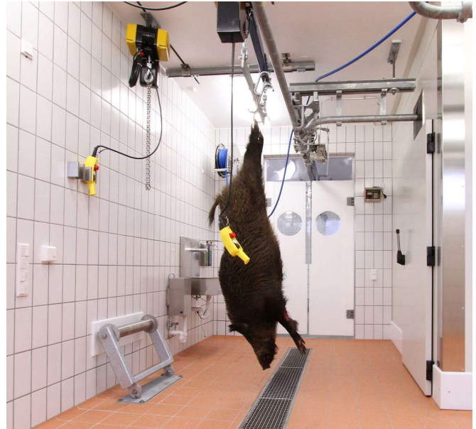
Helle und leicht zu reinigende Wände sowie Entwässerungsrinnen und -abläufe sind Grundbedingung für eine gute Hygienepraxis
